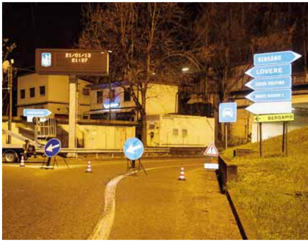
La galleria «Costa Volpino» della statale 42 e la «Loveve» sono chiuse di notte per lavori fino a venerdì FOTO TARZIA
